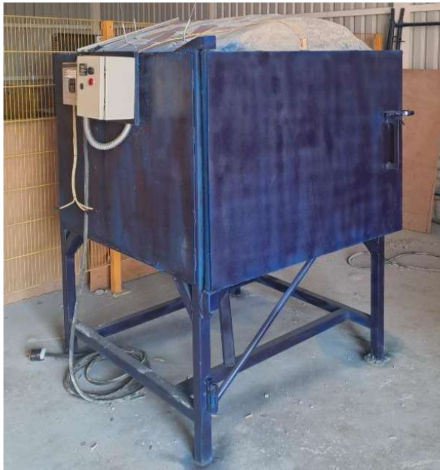
Figura 40. Montaje del tablero de potencia con conexión para alimentación externa trifásica.
